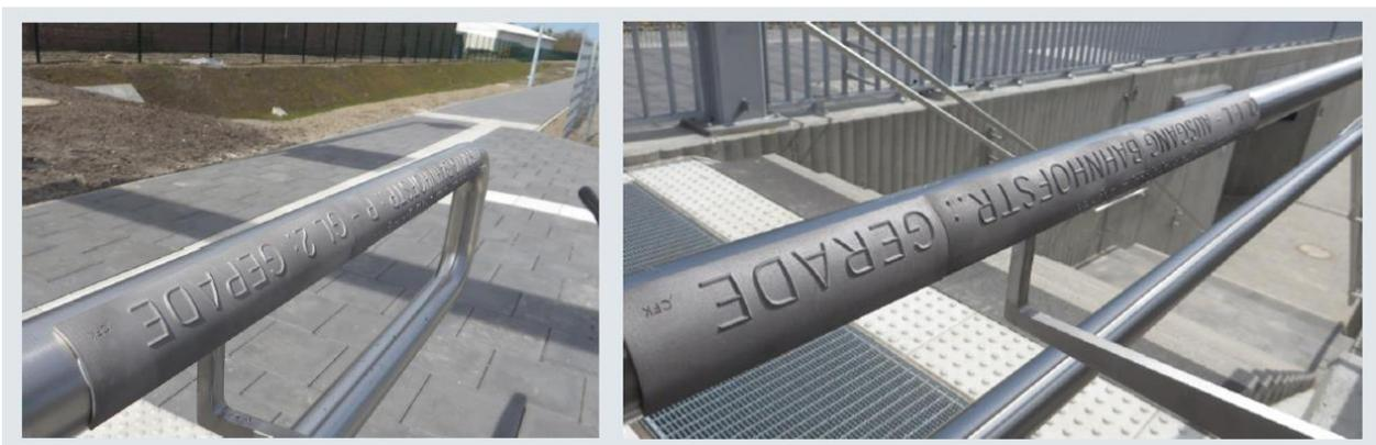
Abb.: Nur eines von vielen recht anschaulichen Beispielen sinnvoller Use Cases der Deutschen Bahn: Kostenersparnis durch additive gegenüber konventioneller Fertigung von 50%. Illustration: Deutsche Bahn AG
